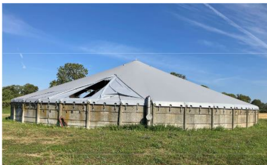
Billede 2 – Gylletank med teltoverdækning, som viser adgangsåbningen og udluftning af gylletanken
