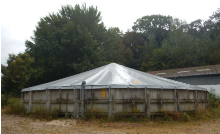
Billede 1 - Gylletank med teltoverdækning foran staldbygningen
